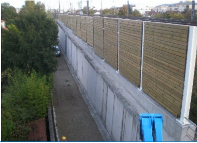
Photo n°1 : Ecran en béton de bois habillé d'un placage bois côté riverain
