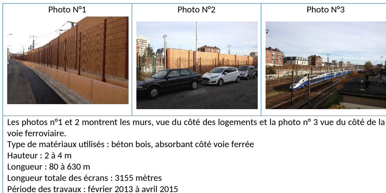
Figure 9: Photos des murs antibruit installés à Noisy-le-Sec et Bondy
