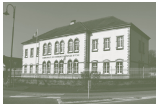
fig. 4 Mutation fonctionnelle du quartier Aynié : implantation du siège de la Communauté de Communes du Pays de Bitche
