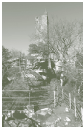
fig. 17 Aménagements sécurisés au château de Waldeck
