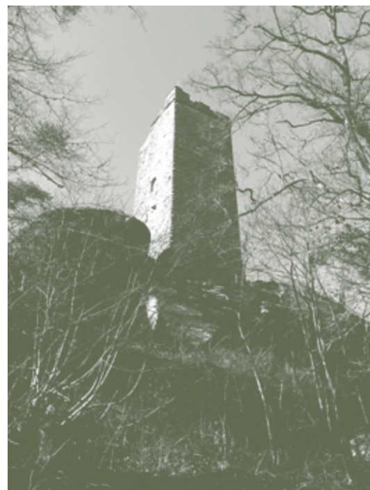
fig. 3 Tour du château de Waldeck
