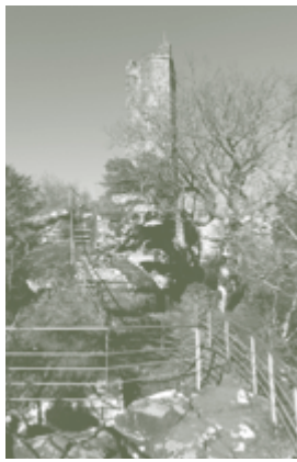
fig. 17 Aménagements sécurisés au château de Waldeck
