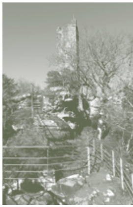
fig. 17 Aménagements sécurisés au château de Waldeck
