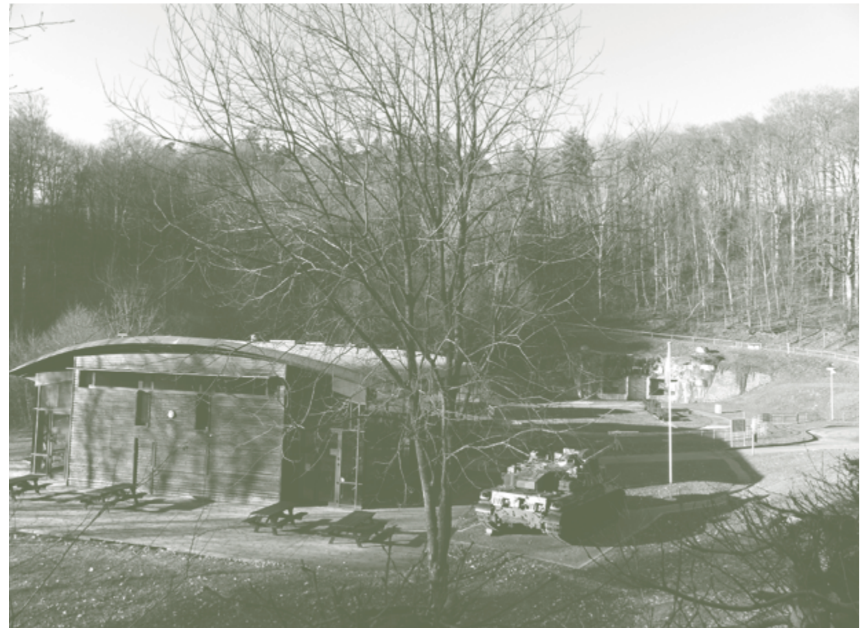
fig. 16 Aménagement touristique de l'entrée du fort du Simserhof
