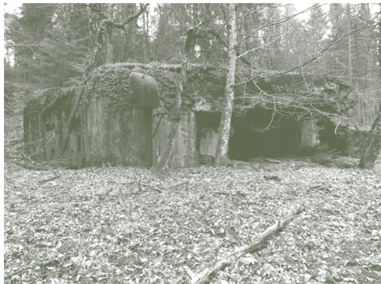
fig. 9 Casemate d'infanterie CORF protégeant les berges du Rothenbach
