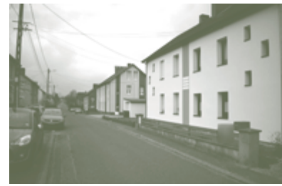
fig. 12 Cités cadres à Rohrbach-lès-Bitche
