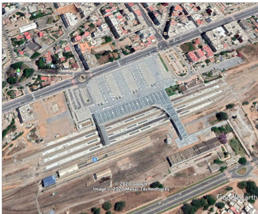
Photo 5 - Vue aérienne de la gare-pont de Kénitra (Document Google Earth)
