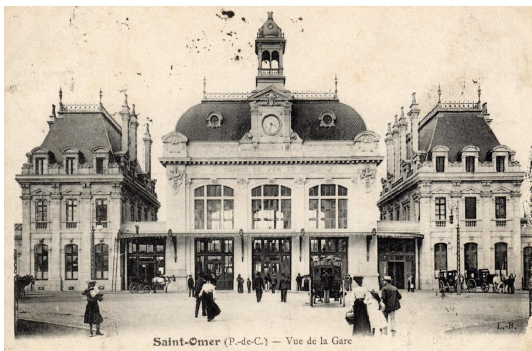
Fig.2 - Bâtiment voyageurs de la gare de Saint-Omer reconstruit et inauguré en 1904 Cartes postales anciennes, XIX e siècle
