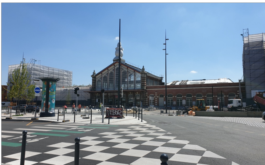
Photo 1 - la gare de Tourcoing (cliché M-A. Lanneaux, mai 2021)
