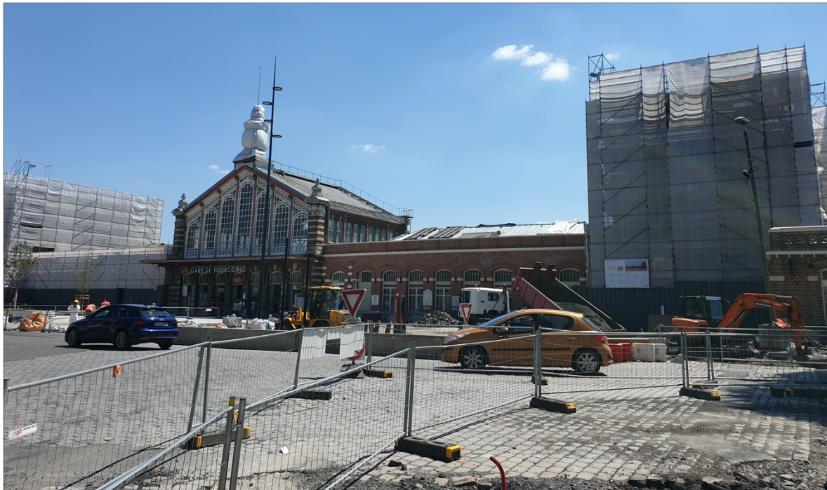
Photo 4 - La gare de Tourcoing et la place Sémard en travaux (cliché M-A. Lanneaux, mai 2021)
