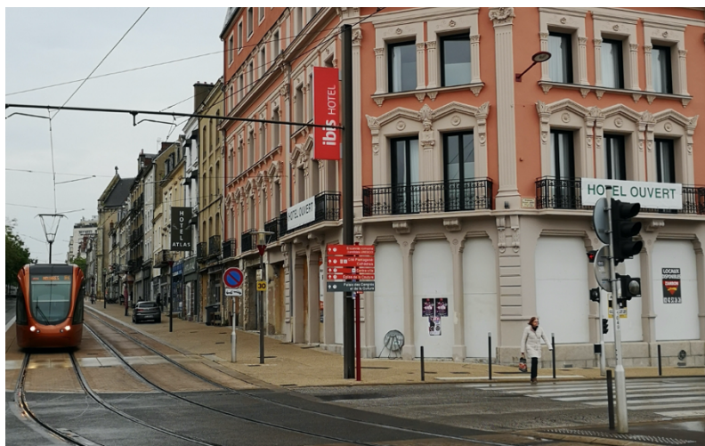
Photo. 4 - Vacance commerciale au rez-de-chaussée de l'hôtel Ibis sur le parvis nord de la gare du Mans (Source ESO, 2021)
