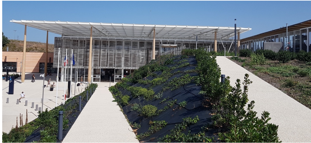
Photo.1 – Gare Nîmes Pont-du-Gard, entrée principale (niveau n) et quai TGV (niveau n+1) (Cliché L.Chapelon, 24 septembre 2021, 13h44)
