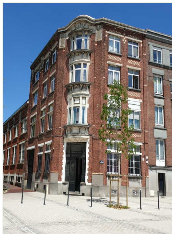
Photo 2 - En face de la gare, une usine textile (inscription laines au fronton) réhabilitée en logements (cliché M-A. Lanneaux, mai 2021)
