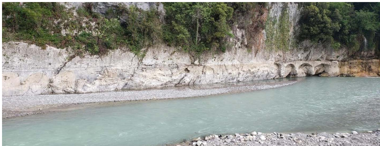
Figure 8. Rive gauche de la Roya en amont de la Giandola : rares arches des anciens canaux de la Route royale encore en place après la crue de 2020. On remarque dans leur continuité les traces des tronçons emportés
