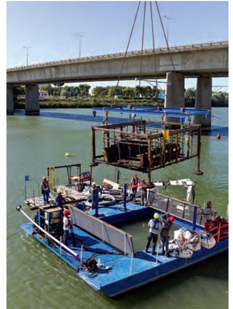
Fig. 27 : Relevage de l'un des tronçons de l'épave dans son berceau, par une grue positionnée à terre (T. Seguin, O'Can-Ipso Facto, MdAa/CG13).
