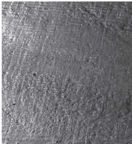
Fig. 250 : Traces de scie de long sur la face externe de la cloison bâbord C11 (L. Roux, O'Can-Ipso Facto, MdAa/CG13).
