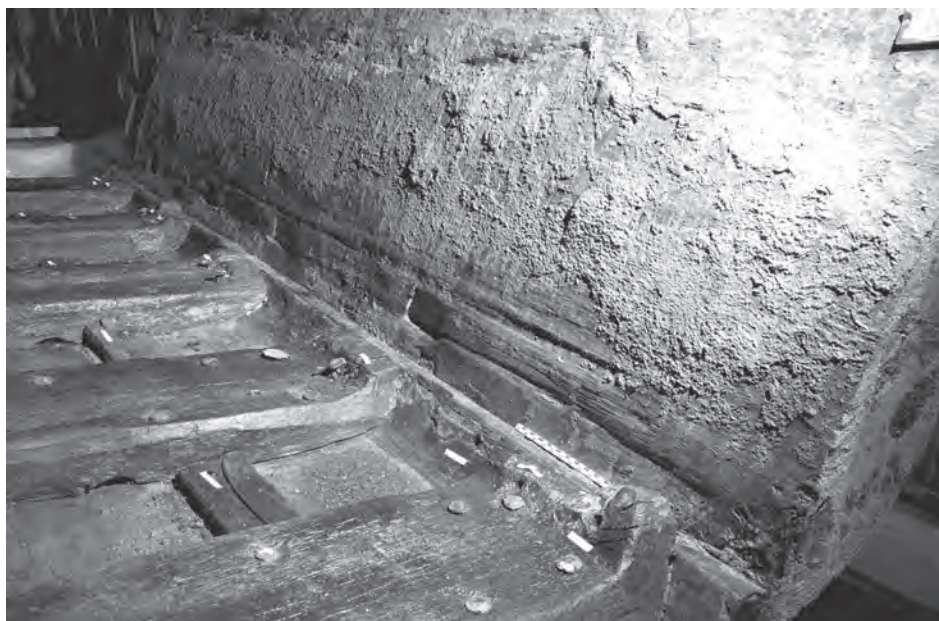
Fig. 116: Base de la face interne du bordé monoxyle de flanc FI2, taillée avec des arêtes parallèles pour une meilleure adhésion du matériau d'étanchéité (T. Seguin, O'Can-Ipso Facto, MdAa/CG13).
