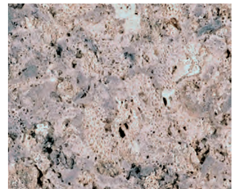
Fig. 316: Vue macroscopique de la texture de la molasse qui constitue les blocs de la cargaison sur la face sciée d'une carotte (P6, hauteur 3 cm) (J. Berthonneau, CICRP).
