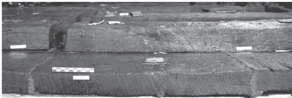
Fig. 115: Vue en section, sur le tronçon T3, des cans des bordages biseautés pour l'apposition du matériau d'étanchéité (T. Seguin, O'Can-Ipso Facto, MdAa/CG13).
