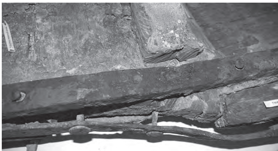
Fig. 110 : Vue, sur bâbord, de la plaque métallique latérale qui est décollée du bois de la coque avec notamment trois clous qui ont sauté et n'ont pas été remplacés (S. Marlier).
