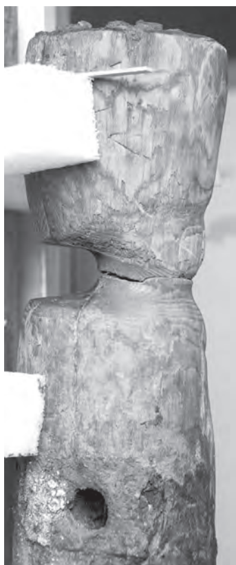
Fig. 267 : Vue de la partie supérieure du mât avec le second cerclage métallique, percé d'un orifice, la gorge et les traces d'usure liées au passage du câble de halage (L. Roux, O'Can-Ipso Facto , MdAa/CG13).
