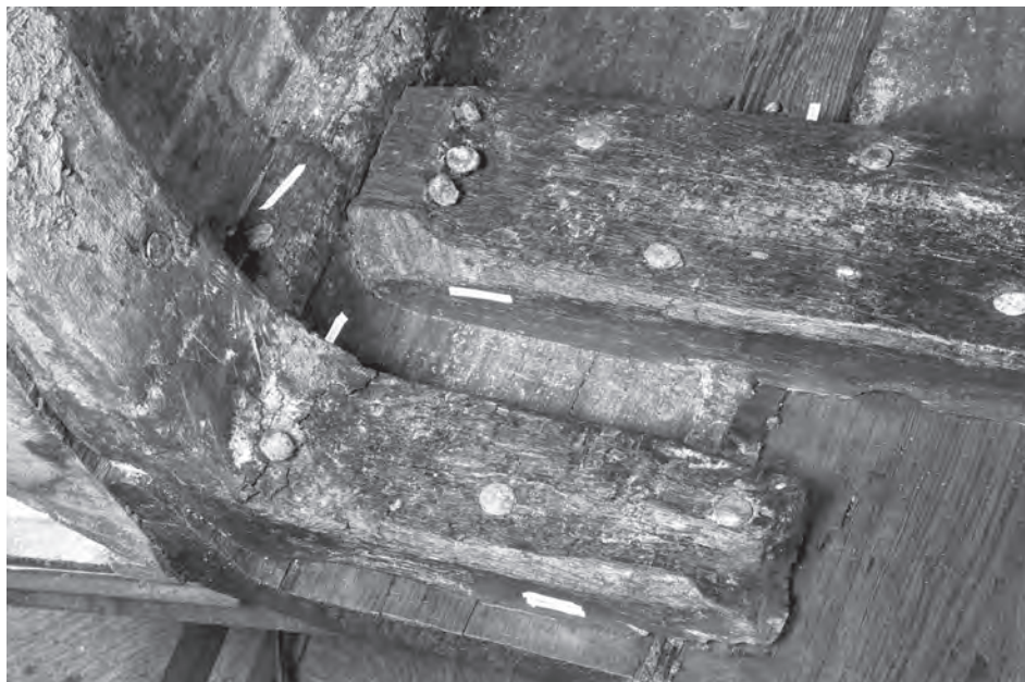
Fig. 76 : Courbe C8 qui présente une ligne de fracture au niveau de son coude (L. Roux, O'Can-Ipso Facto, MdAa/CG13).
