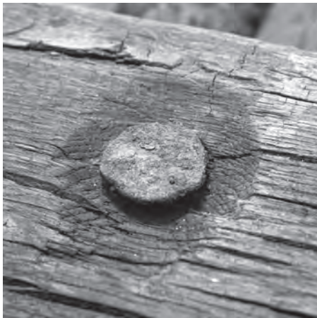
Fig. 147 : Évidement taillé au ciseau, sur le dos de la varangue M124, pour recevoir une tête de clou (R. Bénali/Studio Atlantis, MdAa/CG13).
