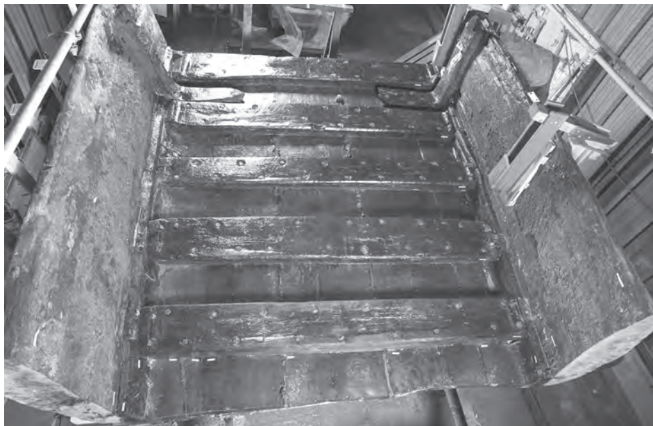
Fig. 72: Vue zénithale du tronçon T7 avec les courbes C10 et C11 affrontées (L. Roux, O'Can-Ipso Facto, MdAa/CG13).
