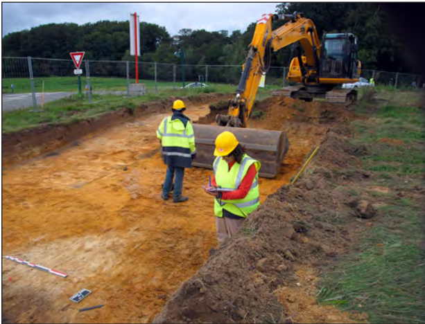
Fig. 3 : Décapage mécanique et enregistrement des structures.
