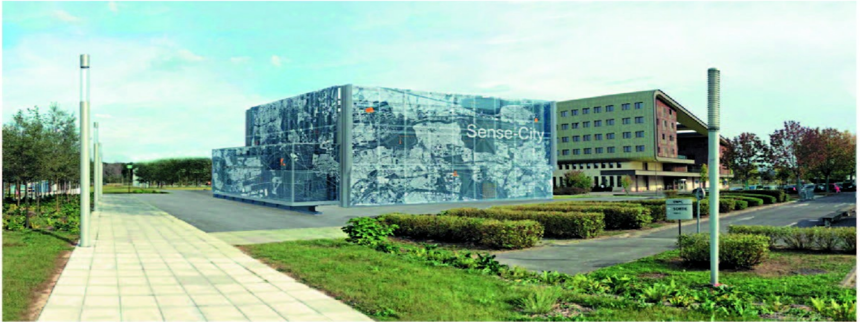
Vue du futur équipement
