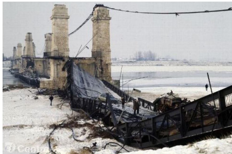
Pont de Sully Sur Loire le 16 janvier 1985
