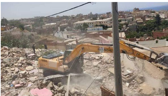
Fig. 2 : «Quartier Kadous el meddah». Mostaganem Opérations de démolition
