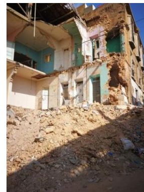
Fig. 3 : "Quartier Cochon ville". Mostaganem, après démolition
