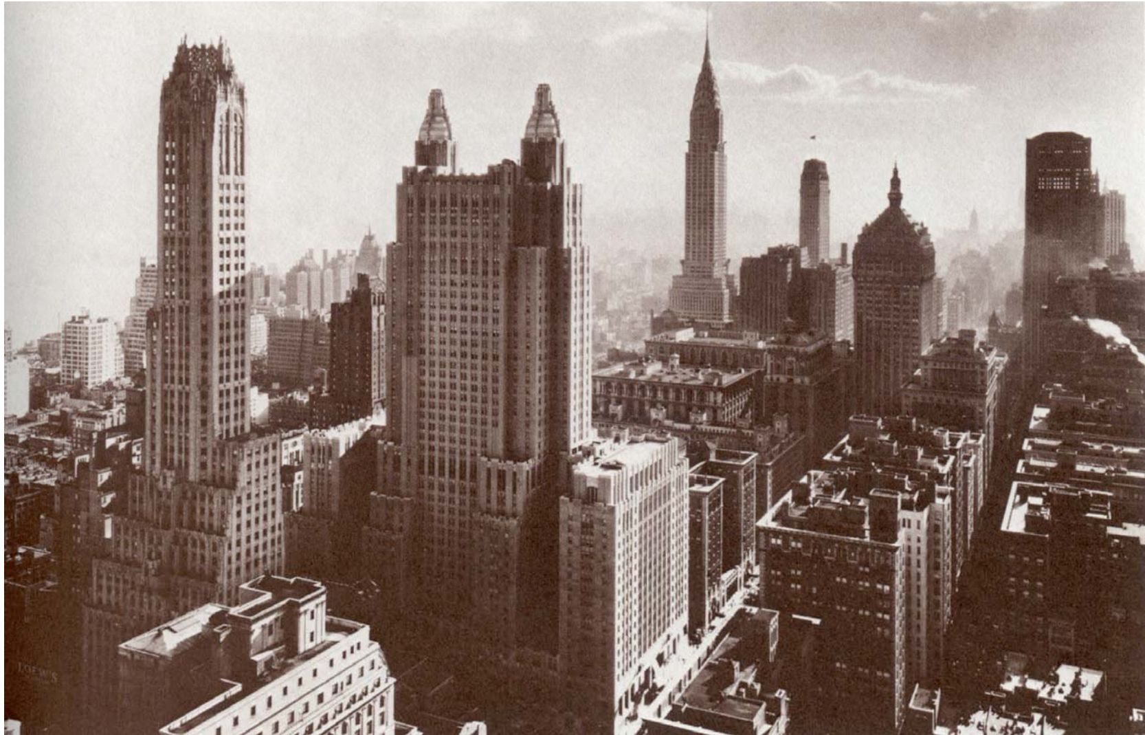
16_ Grand Central City achevée en 1931. La massive unité des bâtiments laisse émerger des repères comme le Waldorf Astoria, le Chrysler (hors zone, mais profitant de la concentration d'activités), le New-York Central Building dans l'axe de Park Avenue. Vue aérienne de Park avenue, depuis la 50 e rue vers le sud, 1931 [NY Public Library, Local History Collection ; [Source : Deborah Nevins (ed.), Grand central terminal , p. 7]
