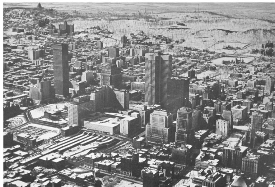
3_Le projet d'urbanisation des terrains du Canadian National (CN) : plan d'ensemble montrant, au centre, les nouveaux ensembles projetés dans l'axe des voies de chemin de fer, et vue aérienne du « skyline » du centre vers 1962 (avec, au fond, le Mont-Royal aux arbres dépouillés de leurs feuilles) [Source : I.M. Pei & associate, Place Ville-Marie, Montréal , Trizec corporation ltd, février 1960 ; L. Knott, La place , 1962, p. 66, cl. H.J. Busse]
