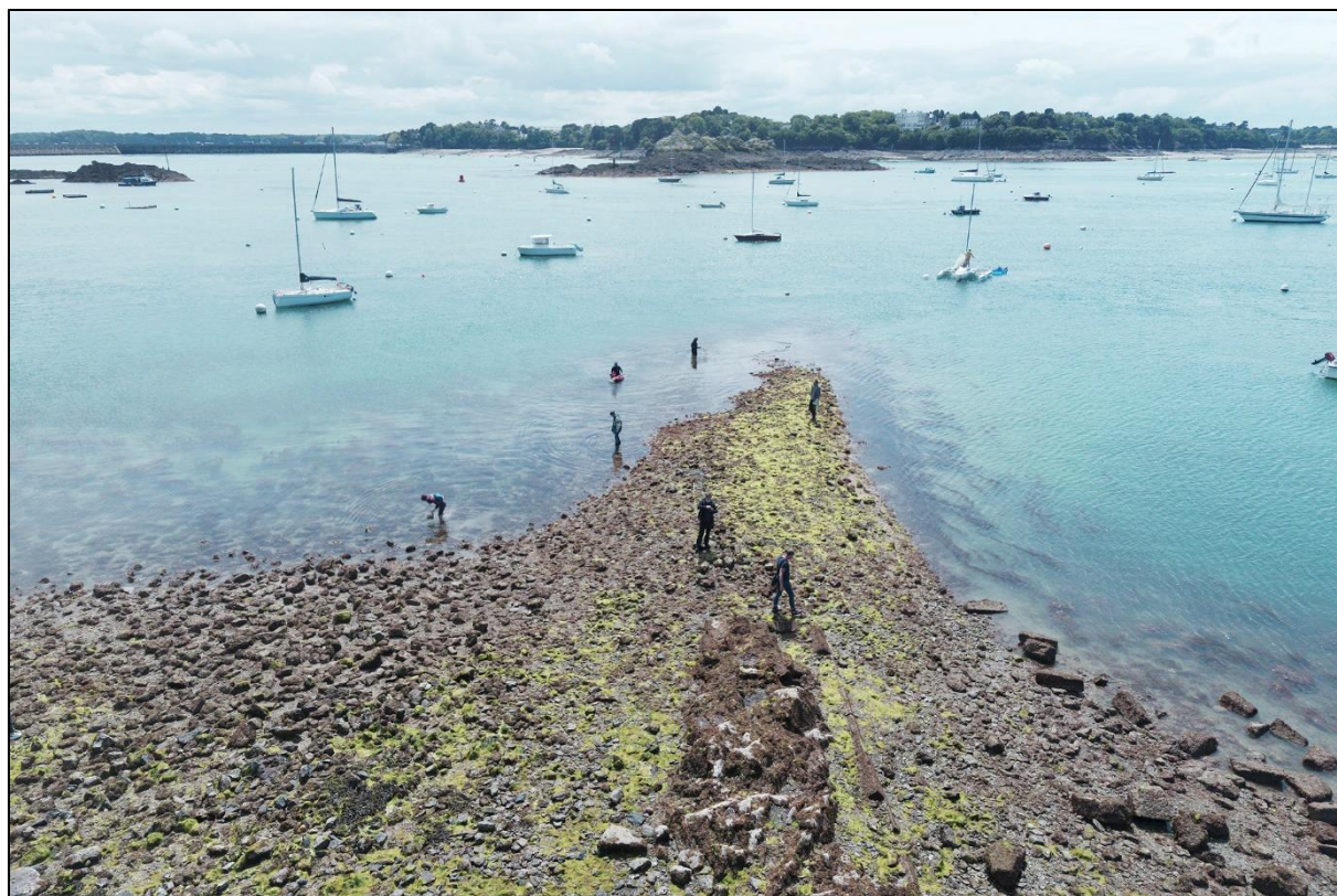
Figure 6 – Vue du drone de l'ouvrage des Corbières.
