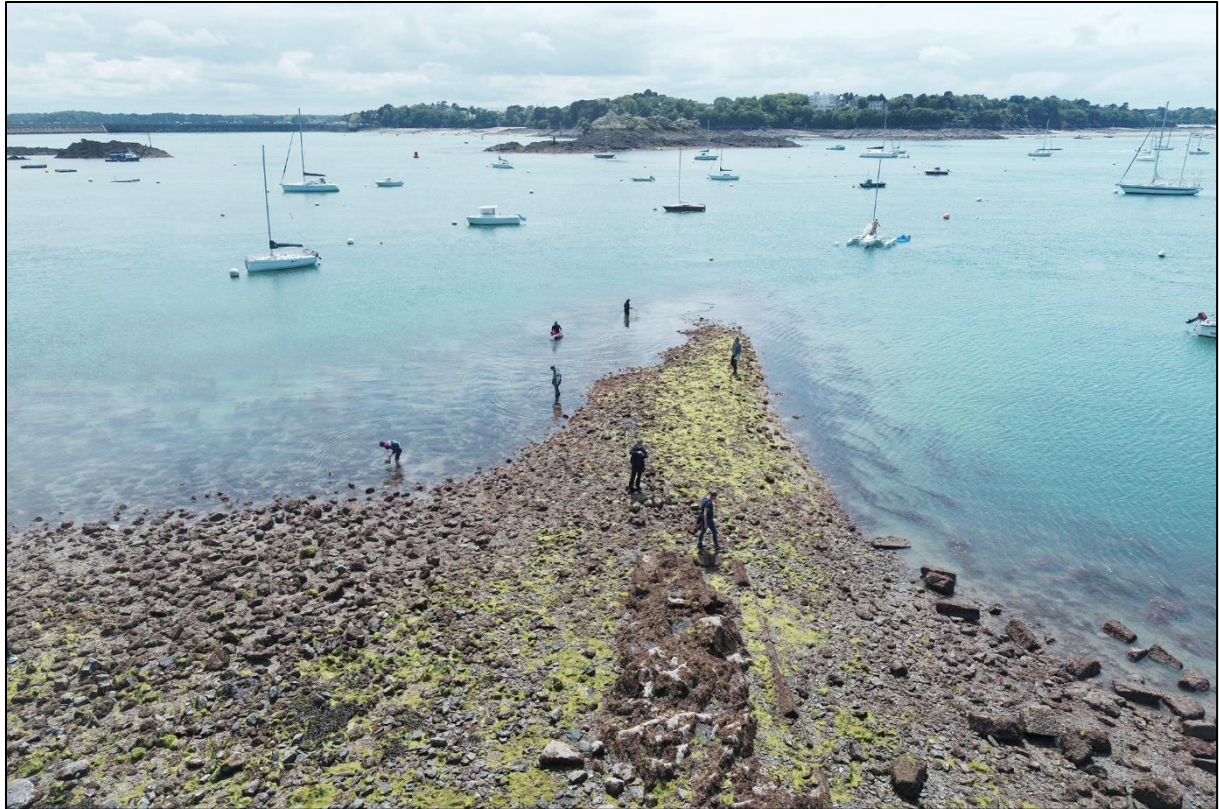
Figure 6 – Vue du drone de l'ouvrage des Corbières.
