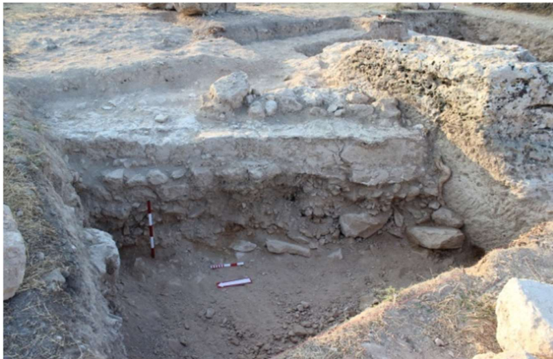
Fig. 40. Sondage IV (partie Nord): arrêt du sondage à l'ouest du mur NE-SE dans le remblai sous le sol à 25.95 m; vue vers l'Est.
