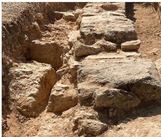
Fig. 17. La roche entaillée (canal rupestre) à l'est du mur Nord-Sud dans l'alignement de l'aqueduc. Vue vers le Sud.
