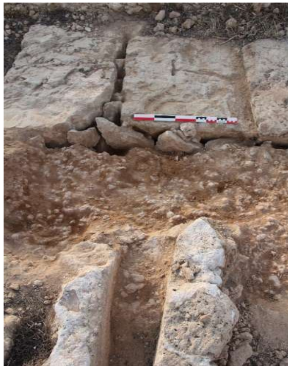
Fig. 40. Au premier plan, l'extrémité coupée de la canalisation rupestre 50 cm à l'ouest de l'aqueduc et, à l'arrière-plan, les pierres de calage des dalles de couverture de l'aqueduc. Vue vers l'Est.
