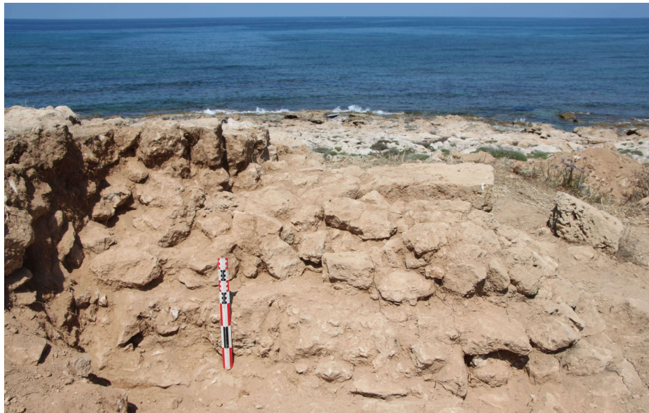
Fig. 28. Effondrement contre la face Est du mur. Vue vers l'Ouest. Cliché : Mañap/M. Tastayre.
