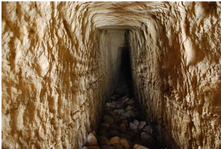
Fig. 123. La galerie Nord de la colline de Fabrika . Vue vers le Nord. Cliché : MafàP/C. Balandier 2011.
