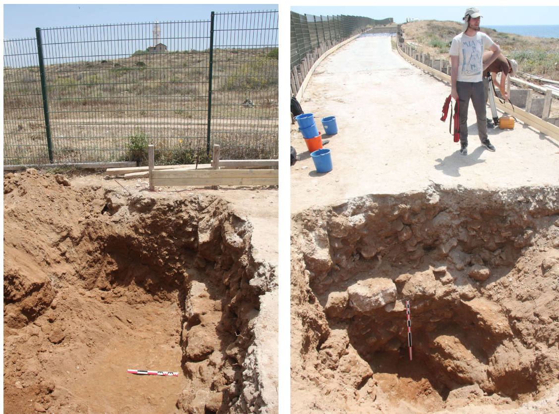
Fig. 8 et 9. Le parement sous la voie piétonne. Vues vers l'Est et le Sud. Clichés : MafaP/C. Balandier
