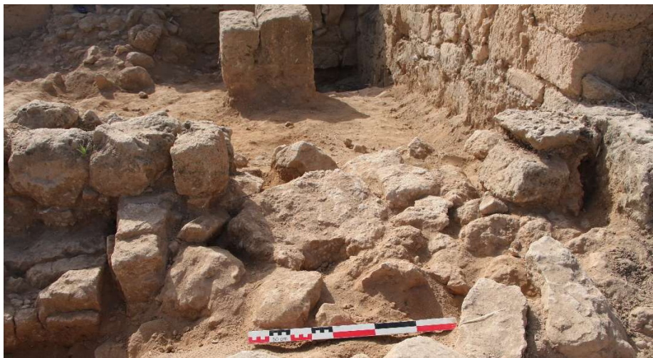
Fig. 104. Le prolongement du mur Ouest vers le Sud : fondation du seuil de la pièce. Vue vers l'Est. Cliché : Mafap/L. Bonnemain.
