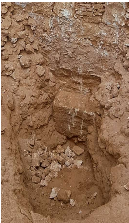
Fig. 26. Le fond du sondage (dans lequel des pierres du remblai sont retombées) : le mur est fondé sur la roche, recouverte de sable et de coquillages. Vue vers le Nord-Est. Cliché : Mafap/C. Balandier.
