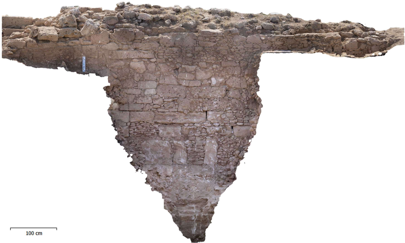
Fig. 23. Le parement Ouest dégagé jusqu'à l'assise de fondation. Réalisé pour la MafâP par T. McClinton (Gettys Institute).
