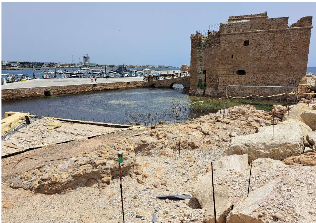
Fig. 70. Prolongement du rempart vers l'Ouest et délimitation des travaux d'extension de la plateforme qui devaient recouvrir ce dernier. Vue vers le Nord-Est. Cliché : MafaP/C. Balandier.
