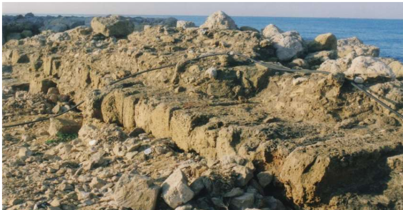
Fig. 66. Détail de l'assise de boutisses (état en 2015). Vue vers le Sud-Est. Cliché : C. Balandier.
