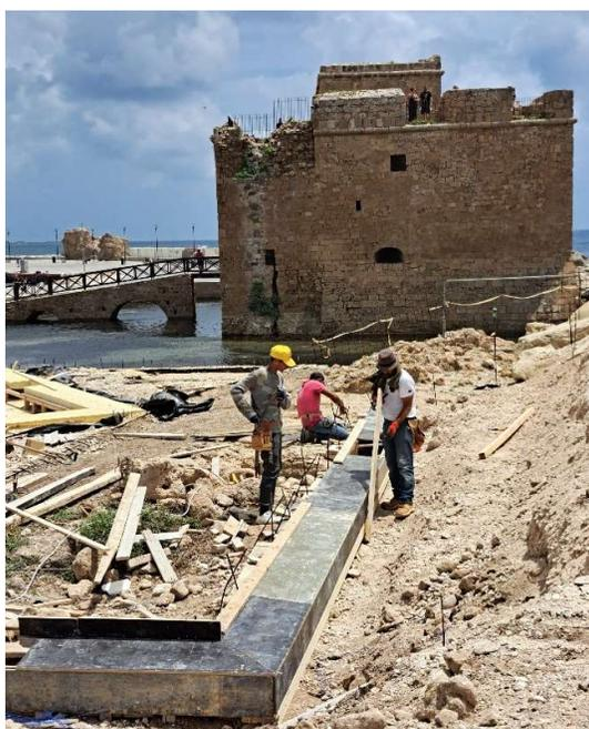
Fig. 71. Le coffrage en cours de construction sur le tracé du rempart. Vue vers l'Est. Cliché : MafaP/C. Balandier.
