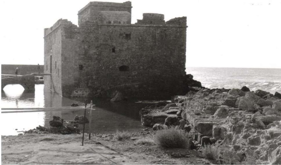
Fig. 64. Rempart Sud à l'ouest du *kastro* : l'assise de blocs disposés en boutisses est bien visible à droite. Vue vers l'Est. Cliché : Department of Antiquities of Cyprus, B.19.852.
