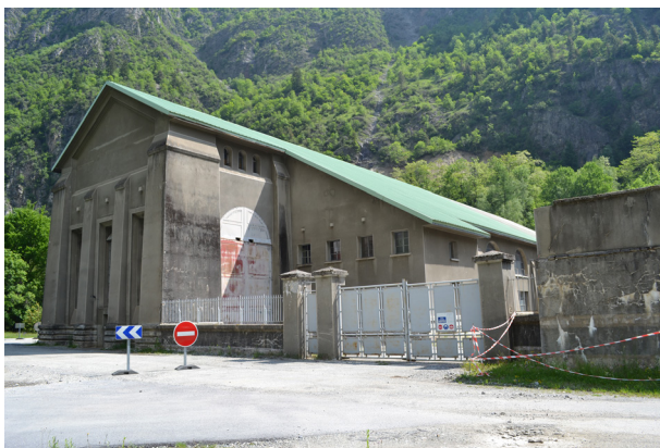
L'usine hydroélectrique de Pont-Escoffier
