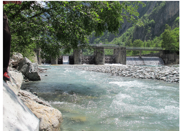
Barrage EDF du Plan du Lac (aval)
