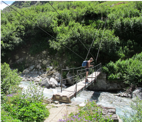
La nouvelle passerelle en aval du Carrelet
