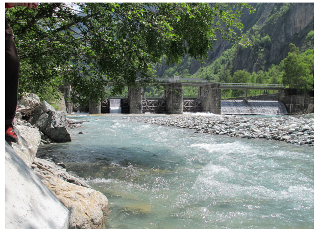
Barrage EDF du Plan du Lac (aval)
