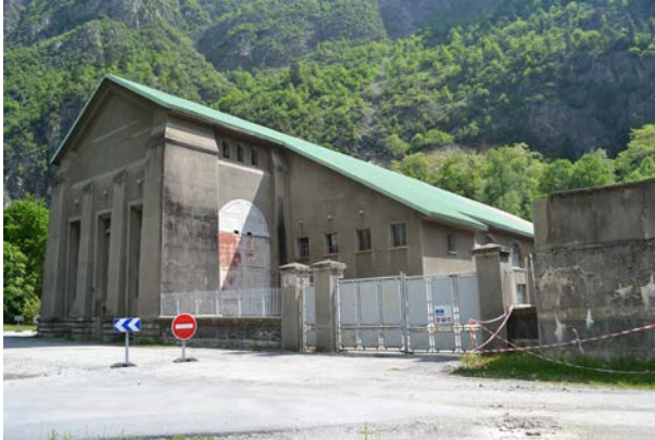
L'usine hydroélectrique de Pont-Escoffier
