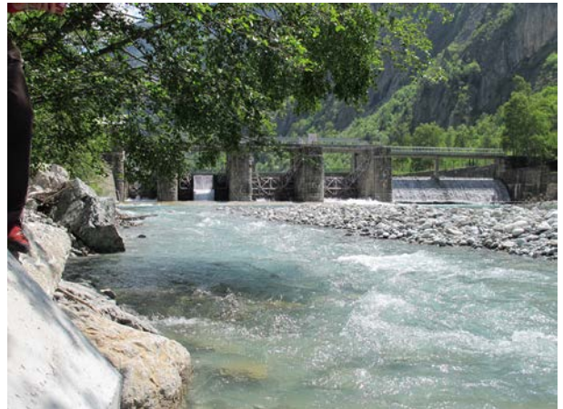
Barrage EDF du Plan du Lac (aval)
