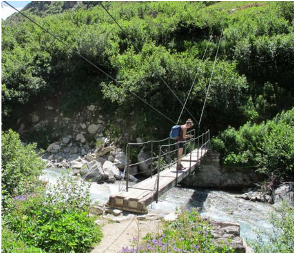
La nouvelle passerelle en aval du Carrelet
