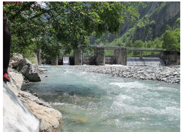
Barrage EDF du Plan du Lac (aval)
