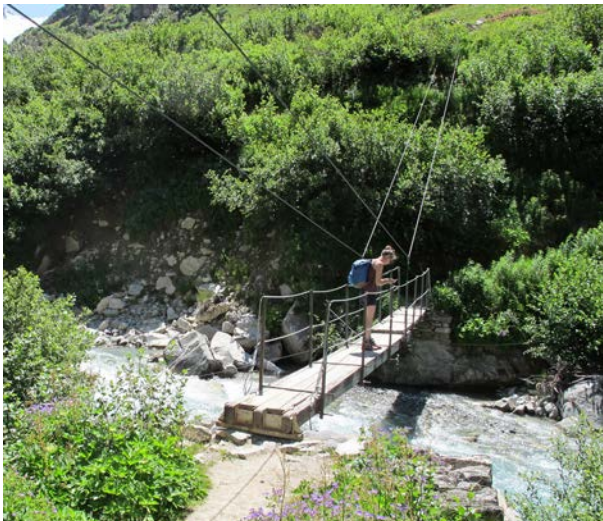
La nouvelle passerelle en aval du Carrelet
