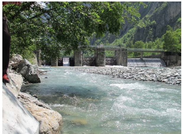
Barrage EDF du Plan du Lac (aval)
