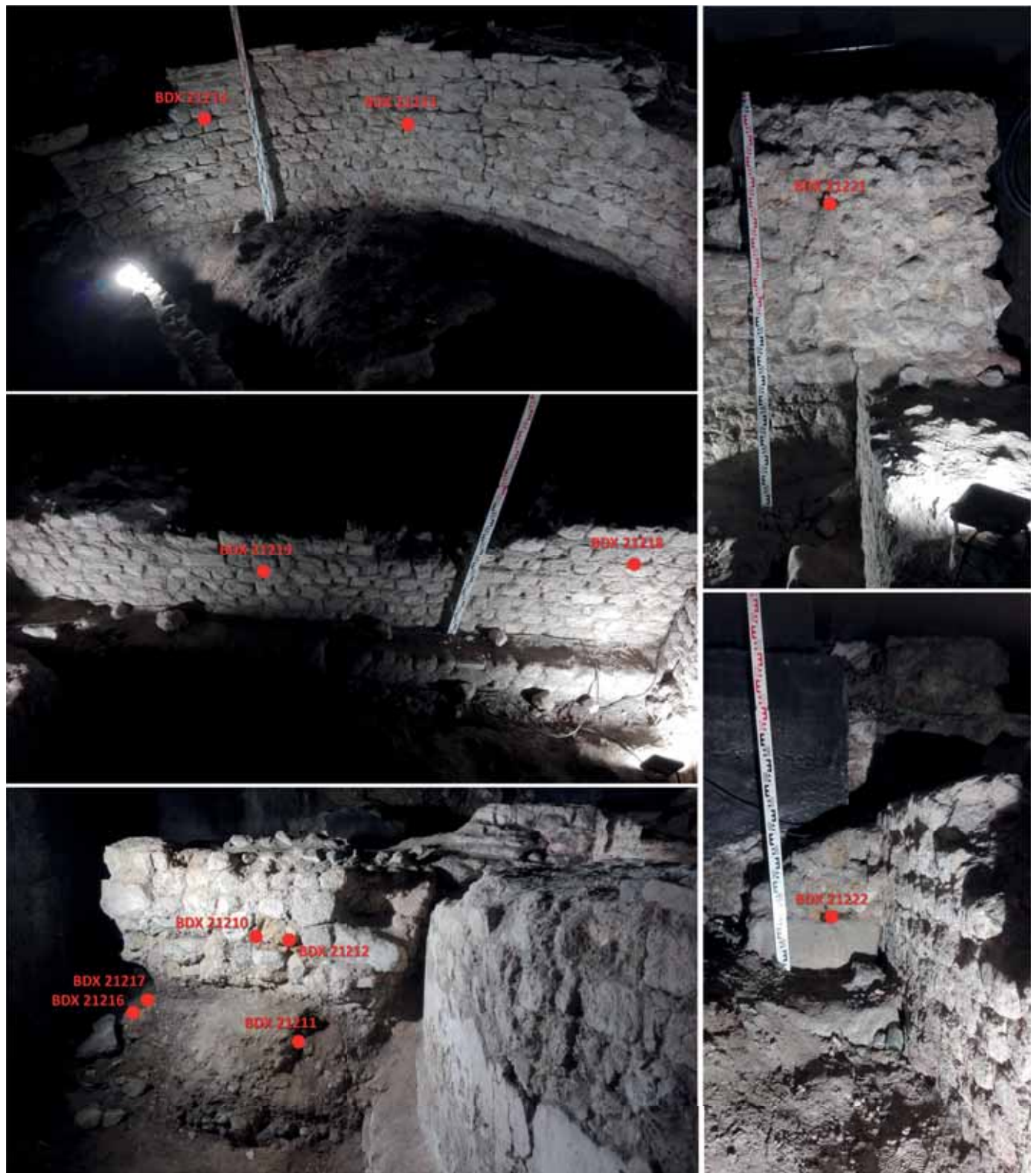
Fig. 9 Localisation des prélèvements des mortiers datés par luminescence optiquement stimulée (technique de single grain). a. Abside, vue de l'intérieur ; b. Mur nord-sud, vue de l'intérieur ; c. Contrefort sud-est (à gauche) soutenant l'abside (à droite), remblai et restes des murs de l'habitat antique ; d. Maçonnerie médiévale ; e. « Pilastre » en remploi (à gauche) et mur nord-sud (à droite).
