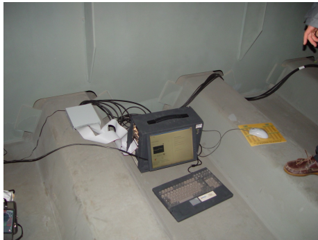
Mesure de déplacement de haubans sur Saint Nazaire (LCPC)
