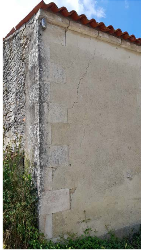
Figure 2-26 : Exemples de bâtiments en maçonnerie de pierres endommagés en degré 2 (commune de Cram-Chaban)
