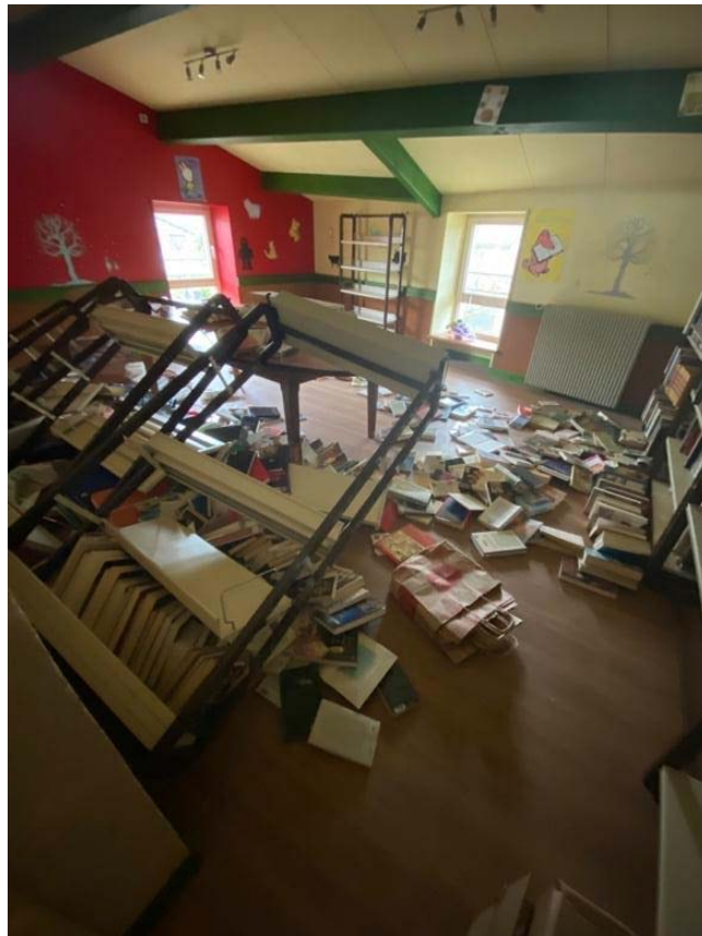
Figure 2-37 : chute d'étagères de la bibliothèque (commune de Cram-Chaban)
