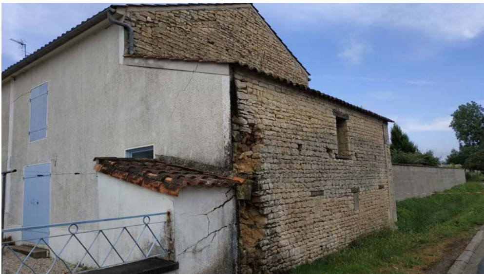
Figure 2-29 : Dislocation à l'angle de deux pignons en pierres brutes d'un parement de pierres taillées (commune de Cram-Chaban).
