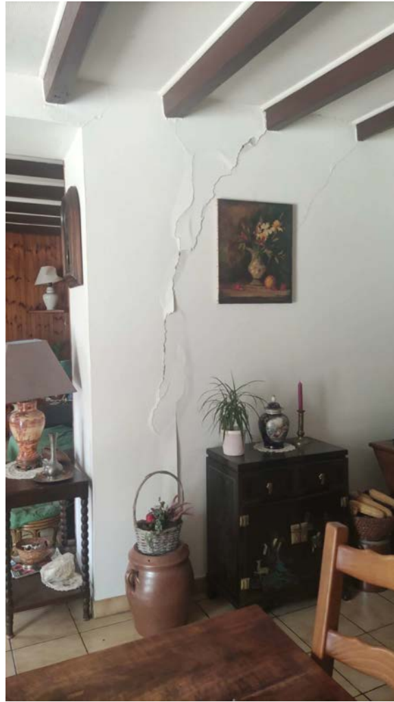
Figure 2-28 : Exemple d'endommagement intérieur de degré 2 sur un mur en maçonnerie de pierres (commune de Cram-Chaban)
