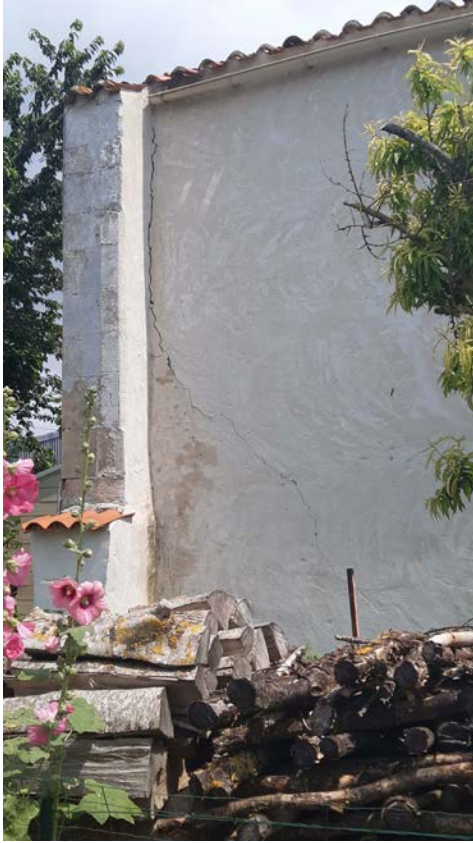
Figure 2-26 : Exemples de bâtiments en maçonnerie de pierres endommagés en degré 2 (commune de Cram-Chaban)
