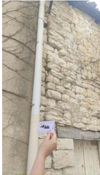
Figure 2-34 : Interaction entre deux bâtiments, et début de poussée hors plan de pierres taillées, (commune de Cram-Chaban).
