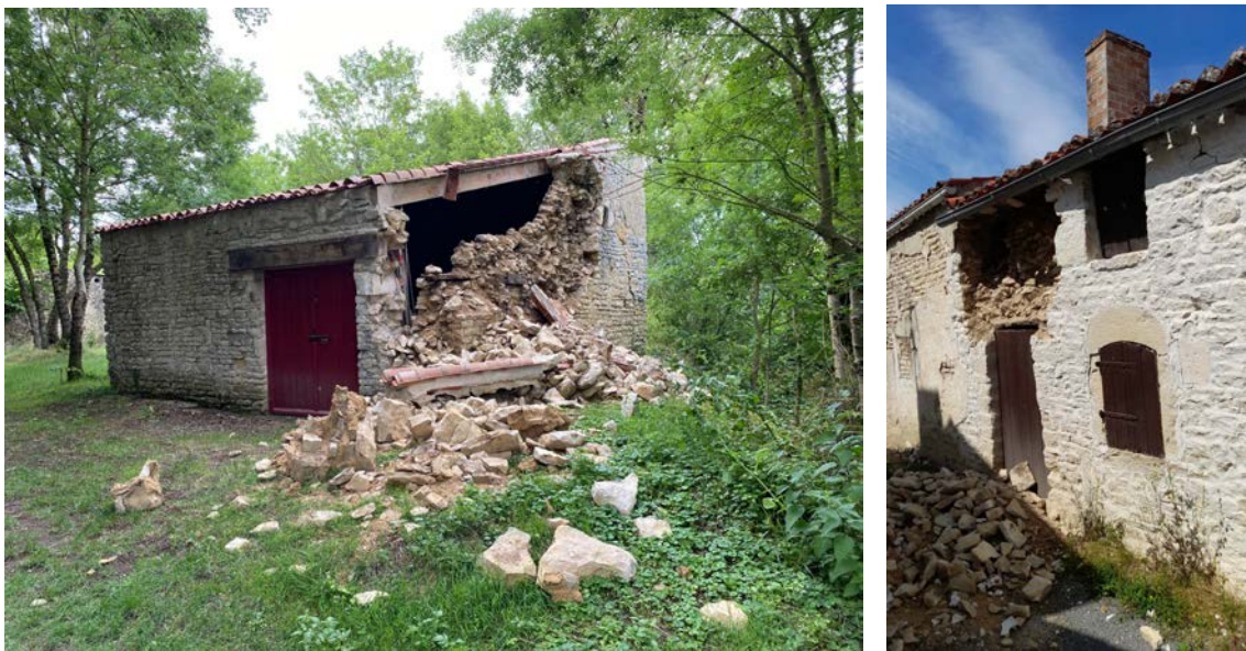
Figure 2-18 : Exemples de dommages de degré 4, ouvertures hors plan de murs porteurs sur des bâtiments en maçonnerie de pierres (commune de La Laigne).
