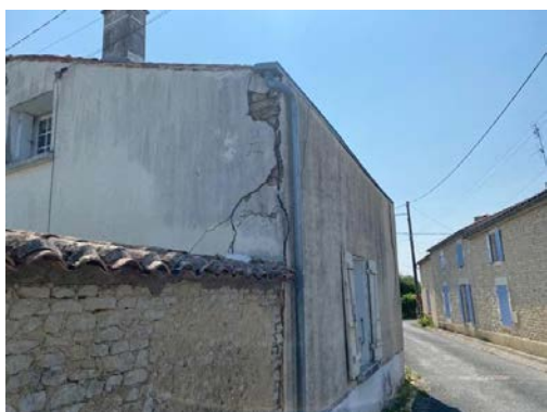
Figure 2-09 : Exemple d'endommagement de degré 3 sur maçonnerie de pierres (commune de La Laigne).
