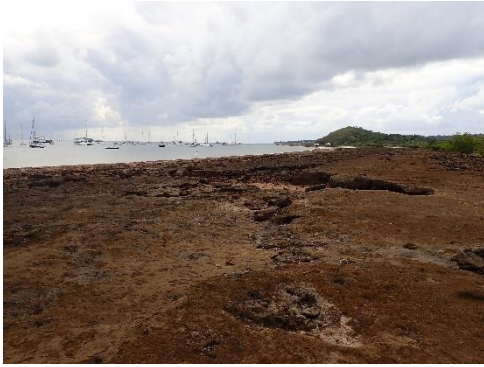
Figure 7 : Cassure entre la partie supérieure et médiolittoral du beachrock
