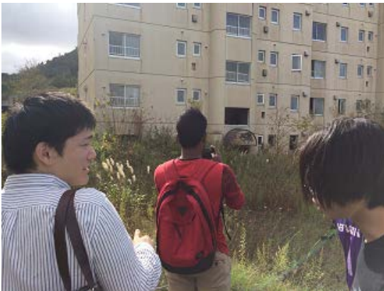
図9 洞爺被災地区の見学(集合住宅)
