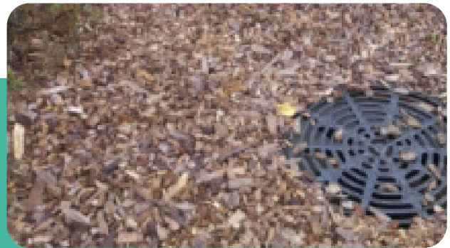
→ Regard vers réseau de connexion des noues d'infiltration
