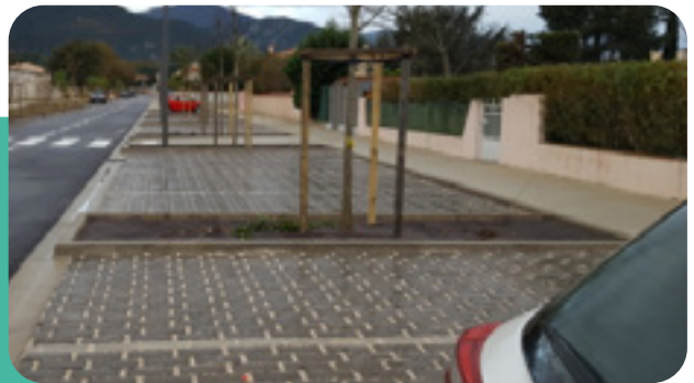
→ Places de stationnement en pavés et graviers
