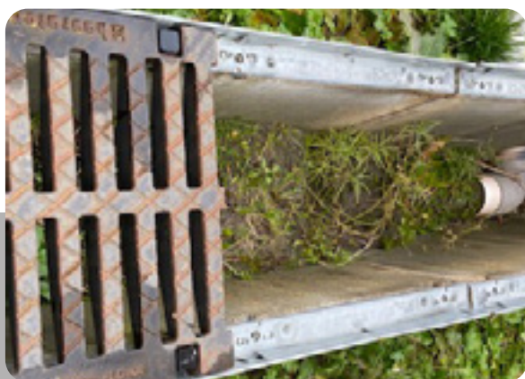
→ La tranchée d'infiltration
