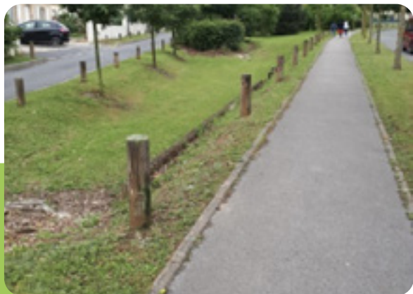
→ La noue d'infiltration
