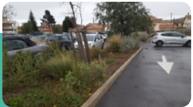
→ Noue d'infiltration sur le parking
