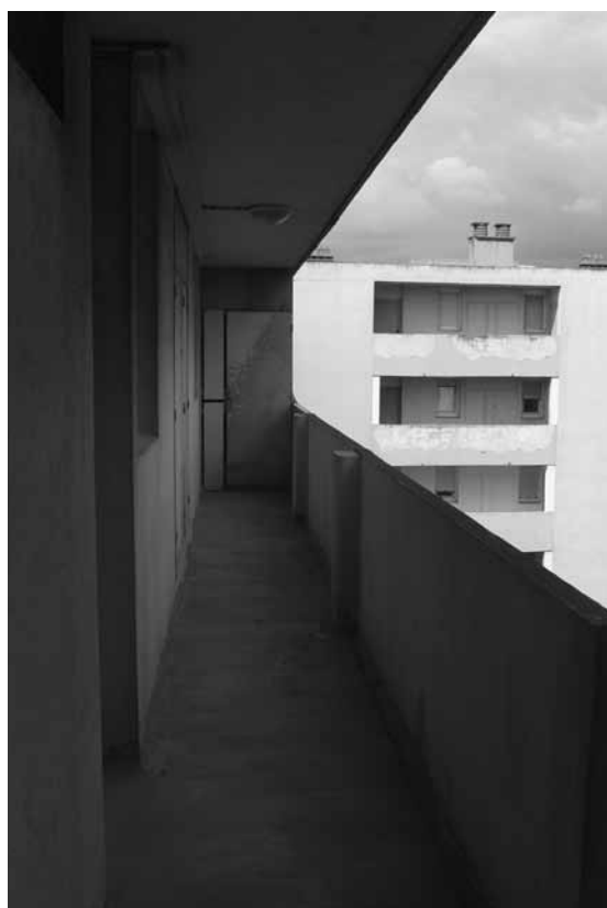
Fig.2 : La cité de l'Étoile à Bobigny (Candilis, Josic Woods architectes). Photo Richard Klein, 2010.
