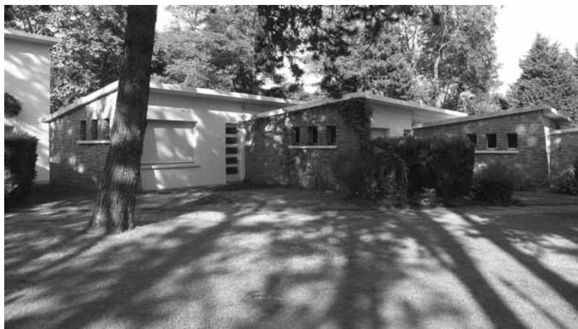
Fig.1 : La résidence Motel du Golf au Touquet-Paris-Plage (Maurice Gridaine architecte), Photo Richard Klein, 2012.
