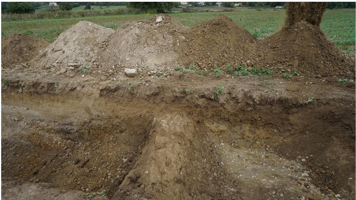
Figure 11: vue de la coupe de la tranchée T1 en cours de creusement. Le bourrelet avec les pierres calcaires visibles au premier plan constitue une couche de remblai du premier état du fossé F 01 (équivalent de la couche n°10 dans le relevé stratigraphique de la coupe)
