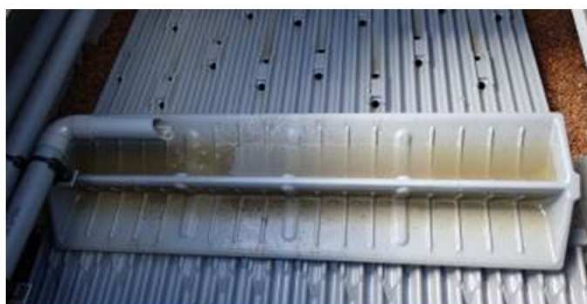
Figure 5. Augets et plaques de distribution perforées
