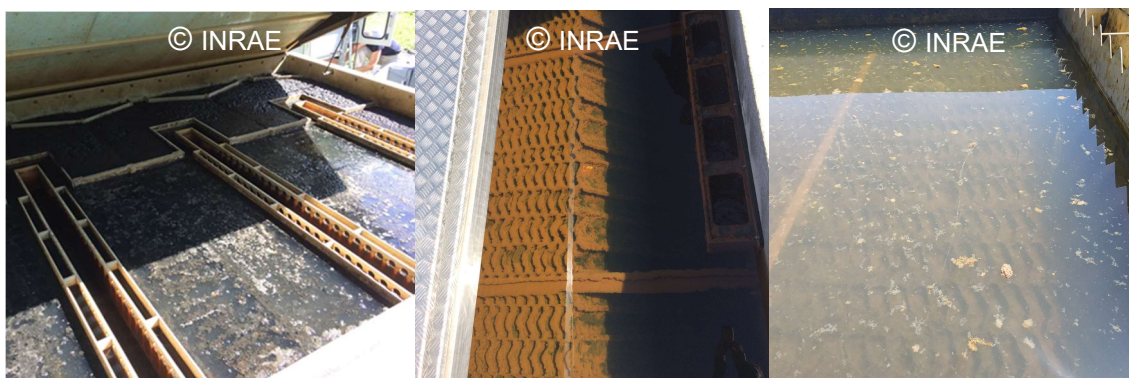
Figure 24 : Exemples de décanteurs lamellaires
