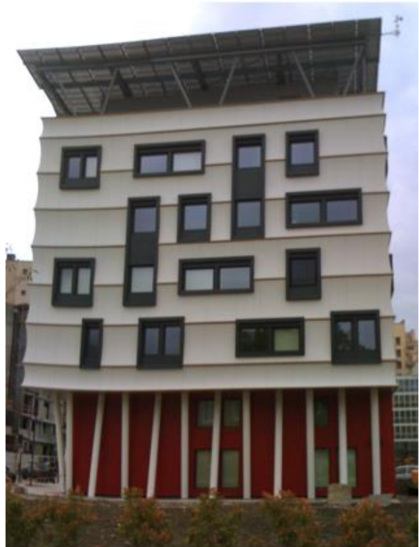
Figure 13 - Immeuble Bonne énergie (Photo Gilles Debizet)
