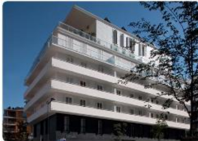
Figure 8 - Immeuble Henri IV (Photo : Ville de Grenoble)
