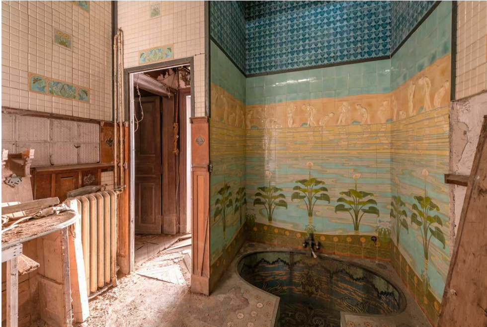
Salle de bains du château Laurens à Agde (Hérault) avant restauration, 2015.
