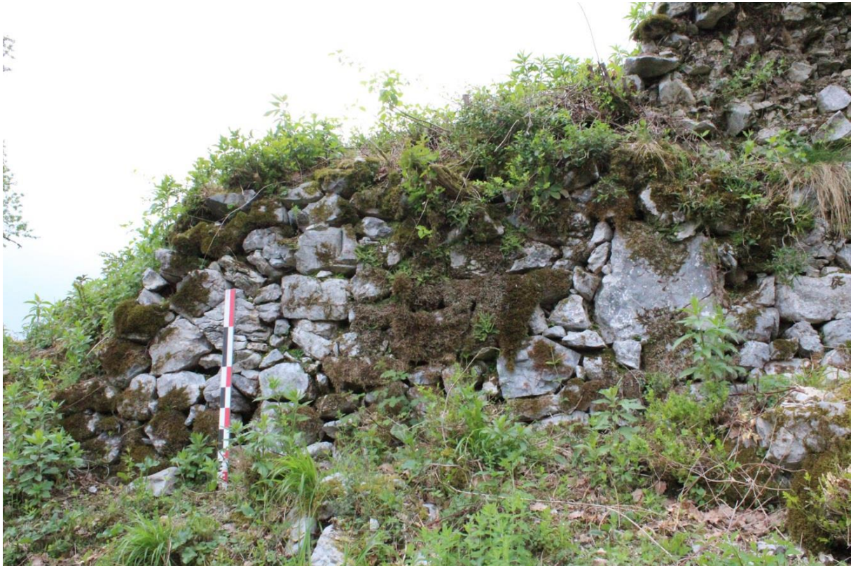
Fig. 15. Parement extérieur des soubassements de l'enceinte villageoise dans sa partie orientale (pour localiser les prises de vue cf. fig.14).
