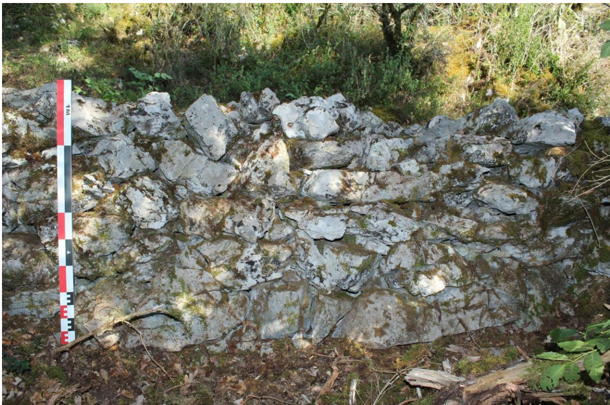
Fig. 10. Le chemin ancien au nord-ouest du site : détail de mur de soutènement construit en pierres sèches et assis sur le socle rocheux (premier segment linéaire du chemin).
