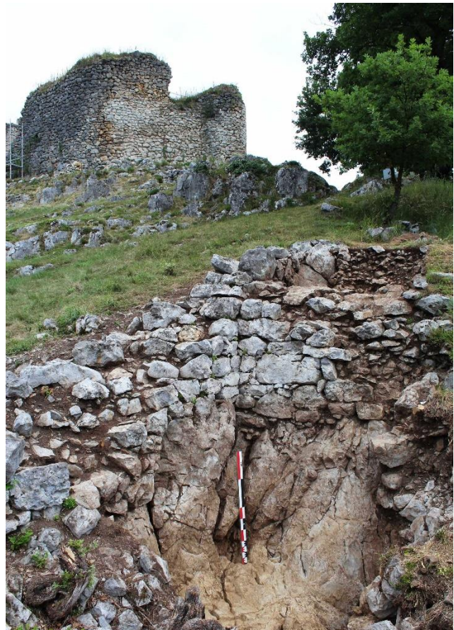
Fig. 2. Angle de bâtiment dégagé dans un des sondages (pièce PCE1, secteur 3), avec retaille du substrat rocheux en palier.
