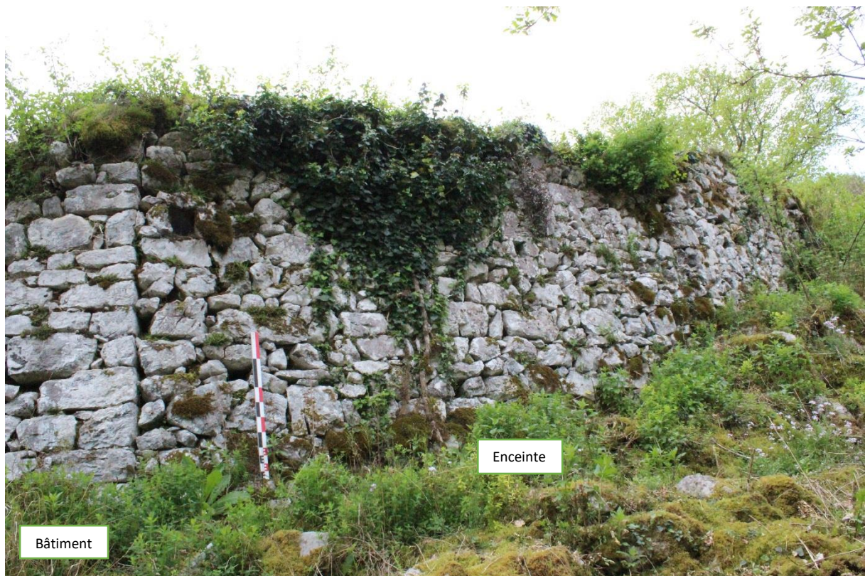
Fig. 16. Le bâtiment au nord-est de l'habitat intra muros et l'enceinte villageoise qui lui est postérieure, venant s'appuyer contre son angle (pour localiser les prises de vue cf. fig. 14).
