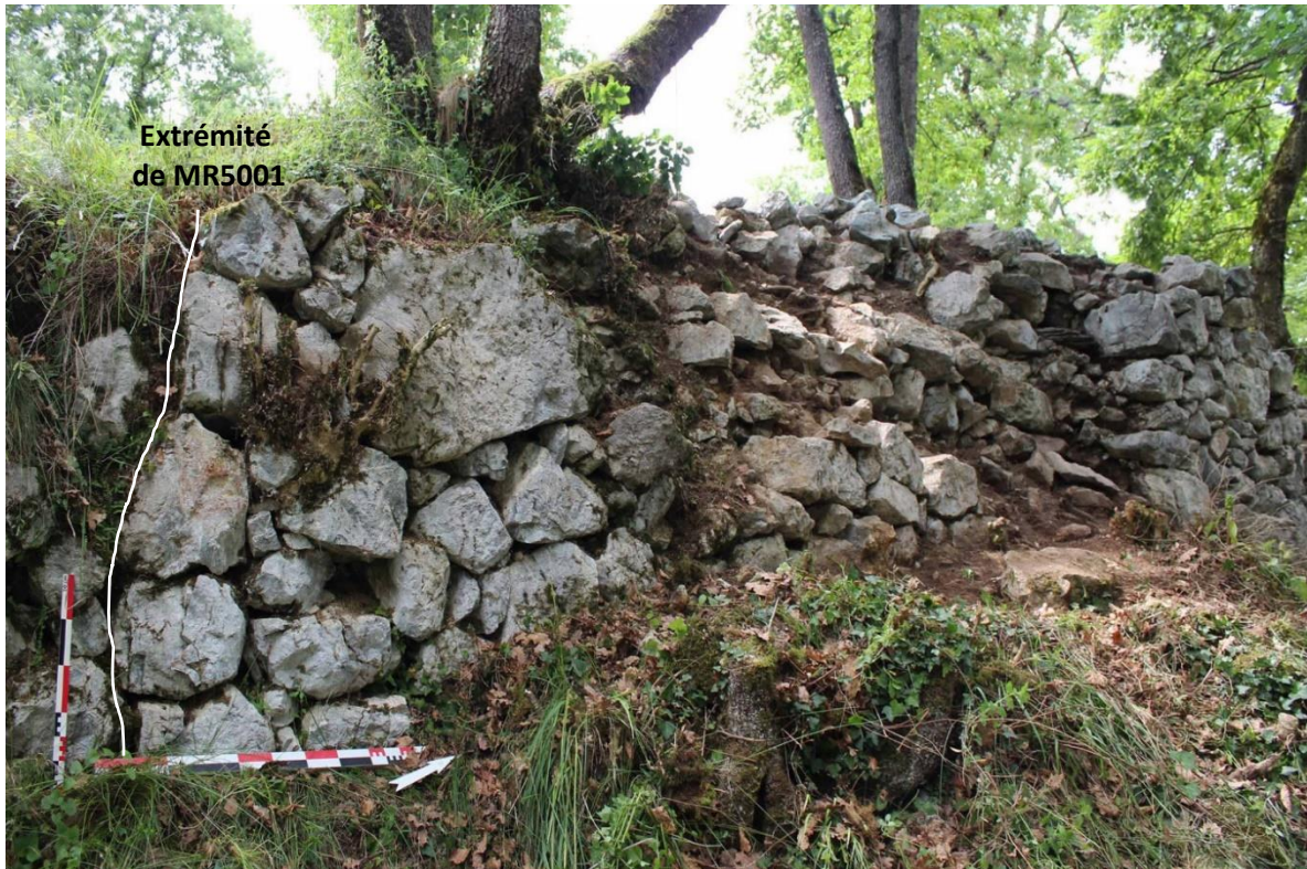
Fig. 57. Parement externe du soubassement de mur MR5001 (UC 5044 - PCE5). À gauche : limite d'angle sud-est et parement oriental du bâtiment. À droite : segment du mur de soutènement en partie effondré. Crédit : T. Lasnier.
