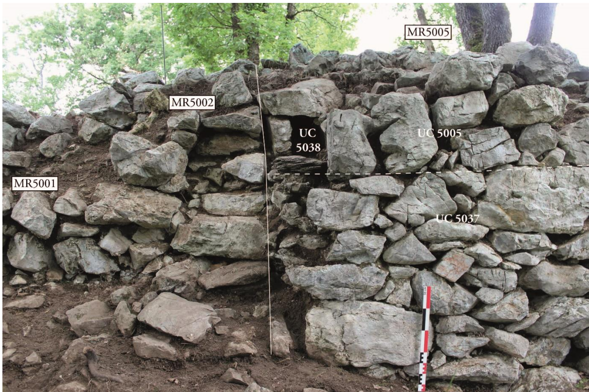
Fig. 72. Vestiges de soubassement (UC 5037) et d'élévation externes (UC 5005) du mur MR5005 au sein de l'espace ESP7, avec son exutoire (UC 5038). Angle nord-est des murs MR5001 et MR5002 (bâtiment PCE5) au contact du mur MR5005 (PCE5). Crédit : T. Lasnier.
