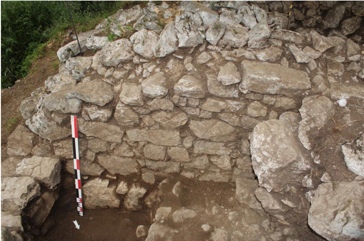
Fig. 33. Parement externe (UC 4003) et fondation (UC 4020) du mur MR4003, au niveau du sondage réalisé dans l'espace ESP4. Crédit : A. Coiffé.
