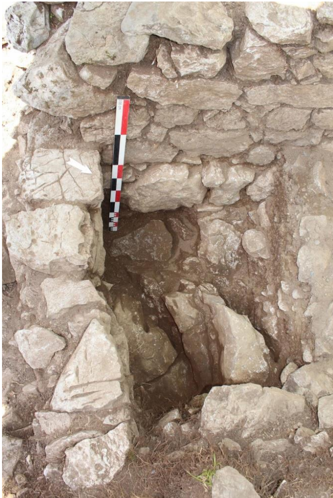
Fig. 45. Détail de la fondation du mur MR4013 (à gauche), appuyée contre le parement externe de la pièce PCE3 (en haut), au sein du sondage de l'espace ESP4. Crédit : A. Coiffé.
