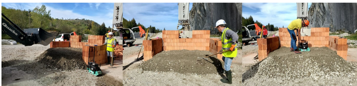
Figure 3.7 Mise en œuvre d'une sous-couche de grave 0-31.5
