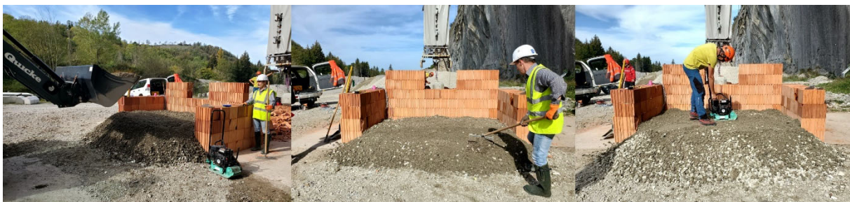
Figure 3.7 Mise en œuvre d'une sous-couche de grave 0-31.5
