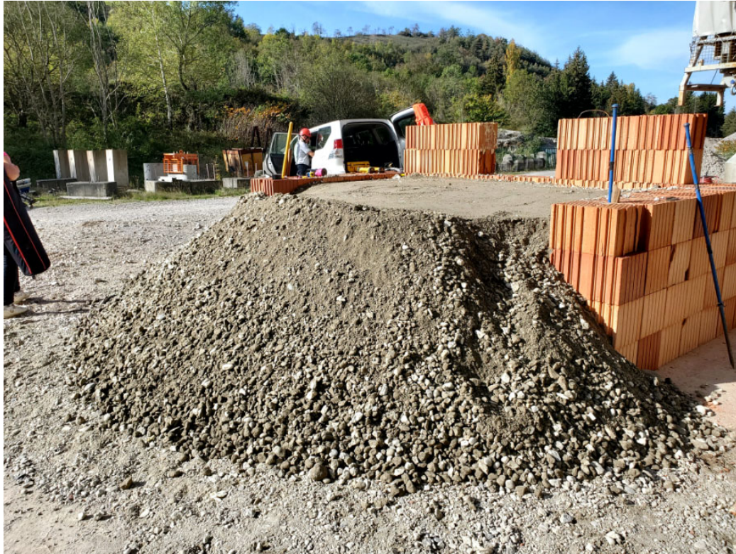
Figure 3.8 Couche de protection terminée
