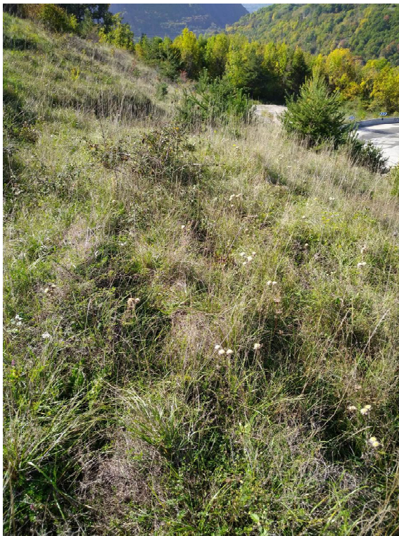
(a) Désordres dans le talus près du lacet
