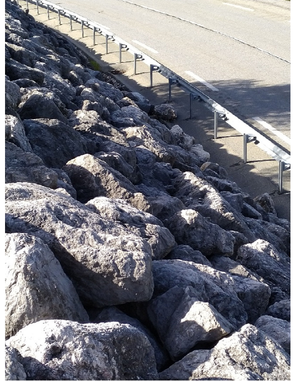
(b) Masque en enrochements en talus de RN
