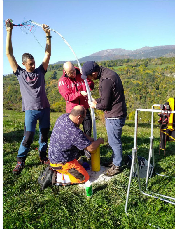
(b) Fin du fonçage dans le tube inclinométrique
