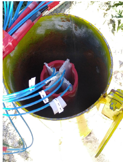
(b) Arrivée et repérage des fibres optiques
