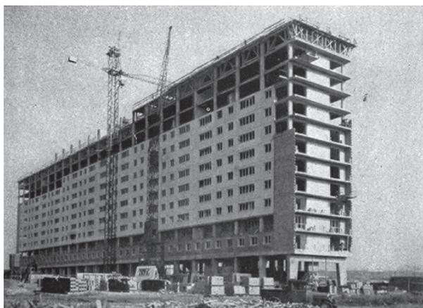
Fig. 4 : Photographie du chantier de l'opération de Nanterre. Techniques et architecture, 17<sup>e</sup> série, n° 5, novembre 1957.
