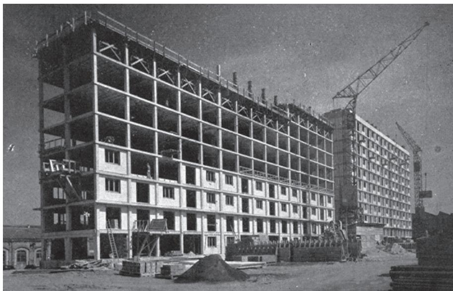
Fig. 2 : Les immeubles du Pont de Sèvres en chantier. *Techniques et architecture*, 17<sup>e</sup> série, n°5, novembre 1957.
