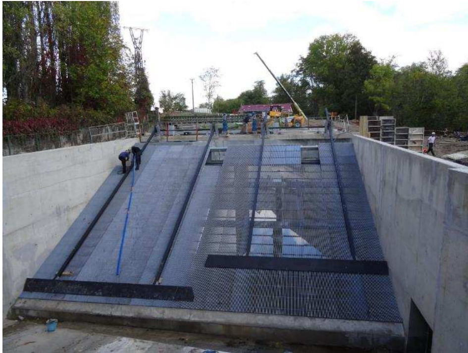
Las Rives (construction)
