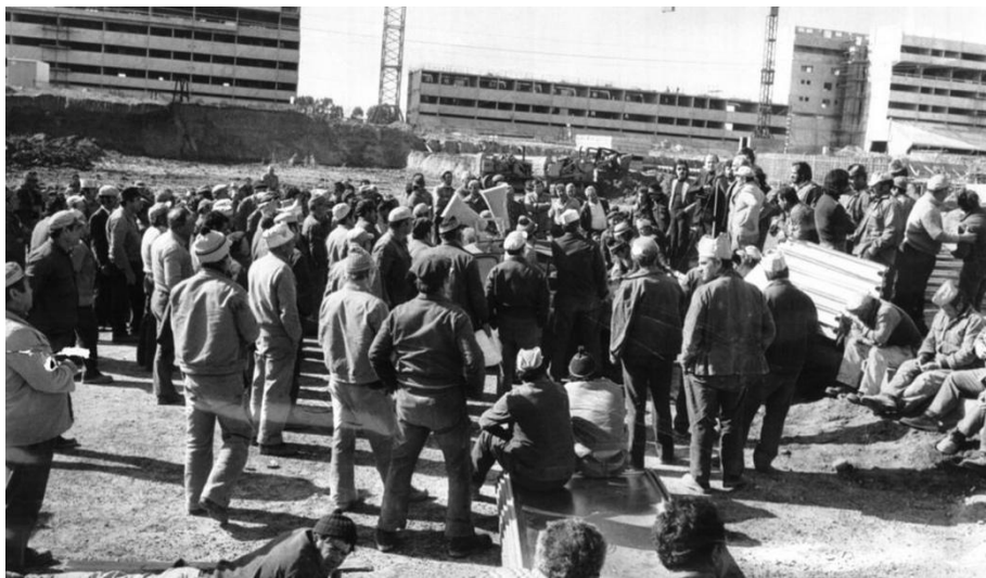
Fig.6: Construction of Corviale, 1973, unknown photographer, Archivio La Unità
