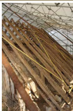
Chapelle, charpente de couverture : versant sud vu depuis le sud-ouest
