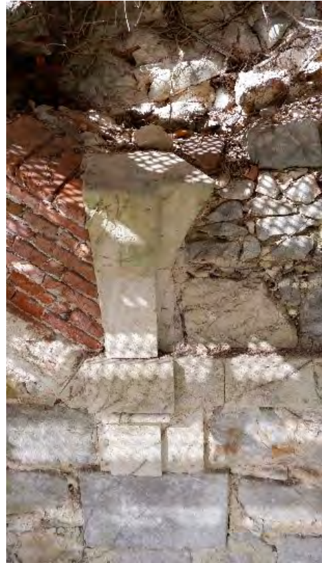
FIG. 48 : Vue de détail de la corniche adossée de l'UC18 et son appareillage fait de pierre de calcaire et briques (Anaëlle Genneret).
