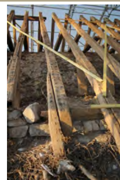
Chapelle, charpente de couverture vue depuis le sud
