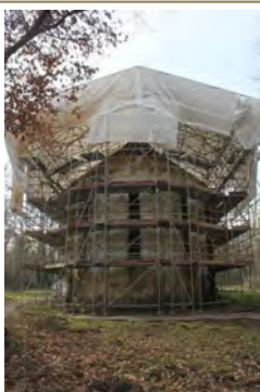
Chapelle : vue depuis l'est
