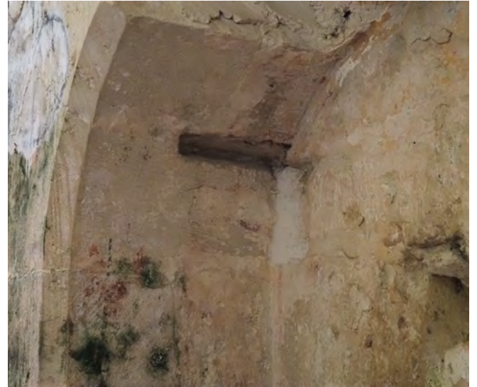
FIG. 54 : Vue de détail de la polychromie sur la voûte du bassin liturgique (UC98). On distingue des tâches ocre d'enduit peint aussi bien sur les pierres de la voûte que celle du fond du renforcement (Mathias Bellat).
