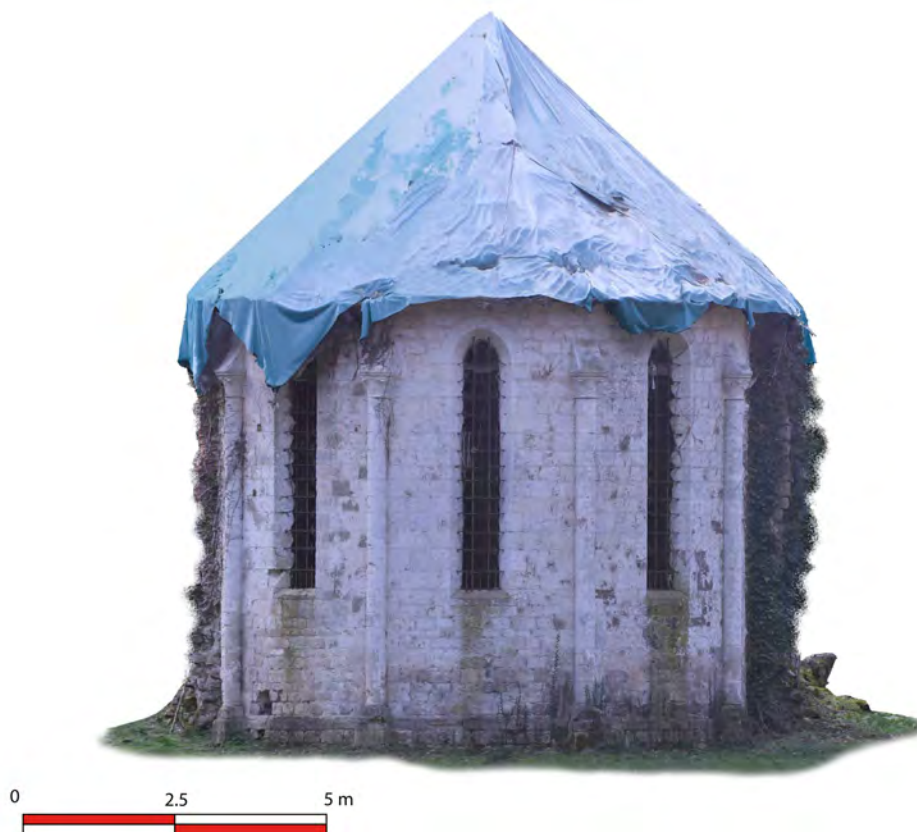
FIG. 45 : Orthophotographie de la façade est du chevet (Photogrammétrie cabinet Bortolussi; D.A.O. Anaëlle Genneret).
