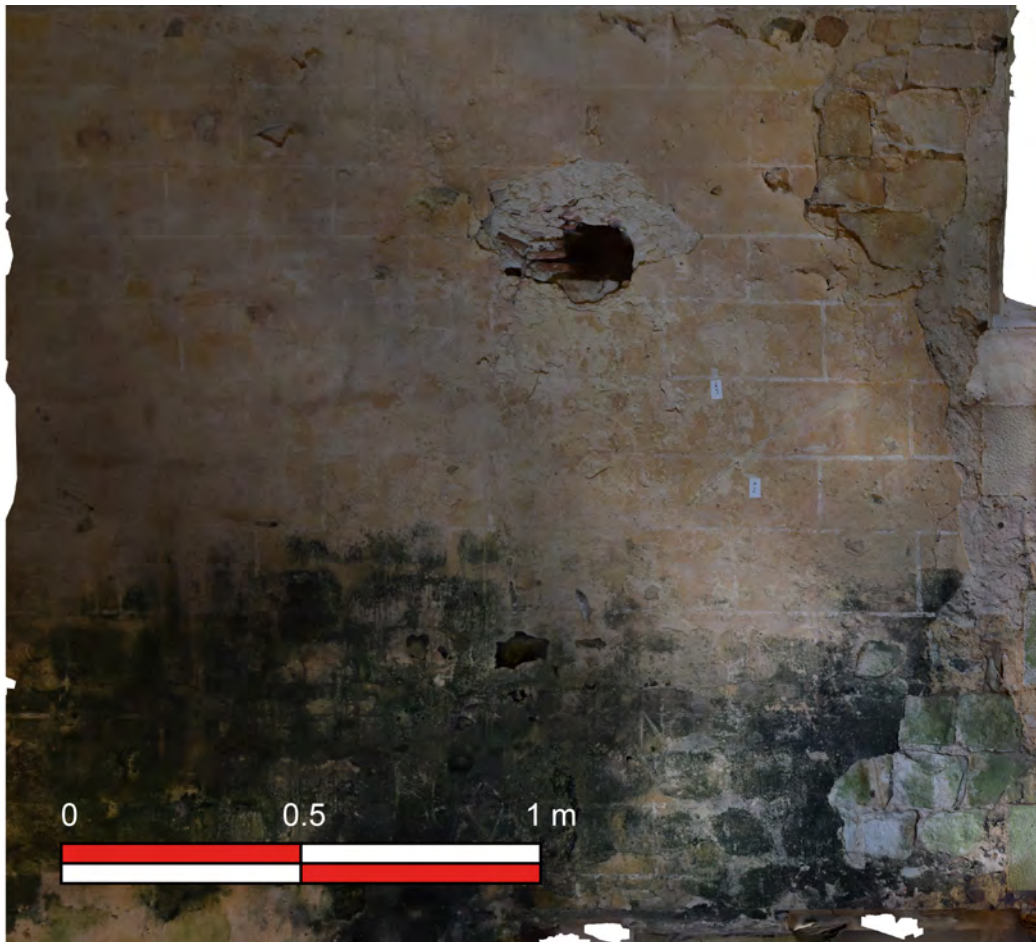
FIG. 55 : Orthophotographie de la façade sud du balcon prise depuis le nord. Le trou de boulin UC54, de part ses dimensions, sa position au-dessus de la tribune et sa connections avec l'UC43, semble être un élément moderne en lien avec la tribune. il pourrait s'agir d'une poutre de soutènement d'un rideau ou divers éléments décoratifs (Aaron Gatt).
