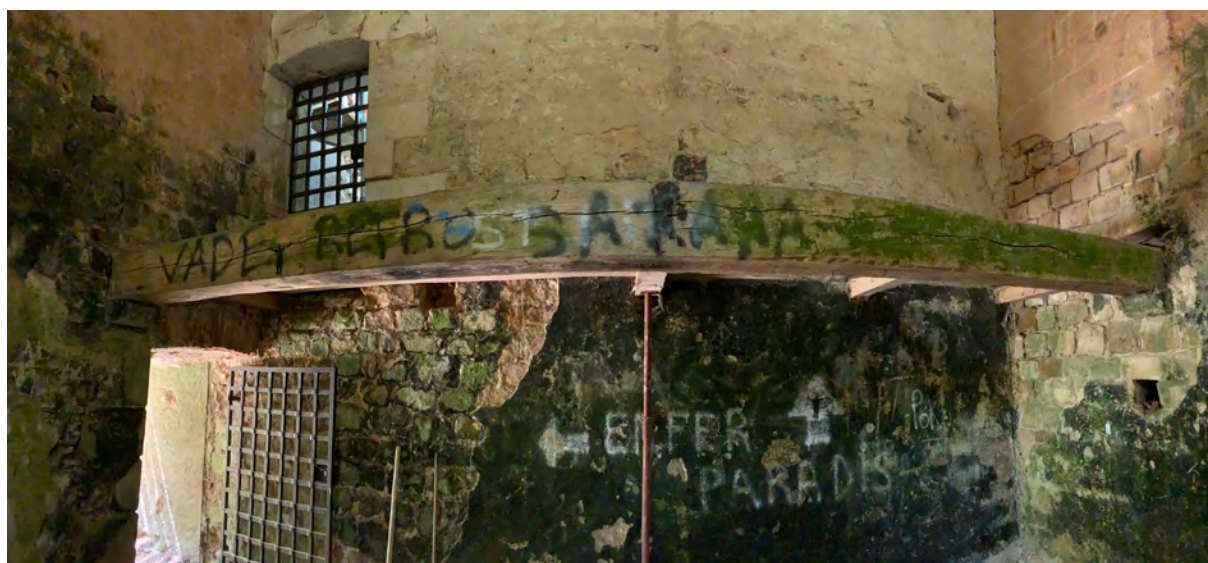
FIG. 51 : Prise de vue, fisheye, de la face est de la nef depuis l'ouest avec le balcon daté de la période moderne et sa poutre traverse. On observe au sud une ouverture sur la partie supérieure (UC74) (Araon Gatt).
