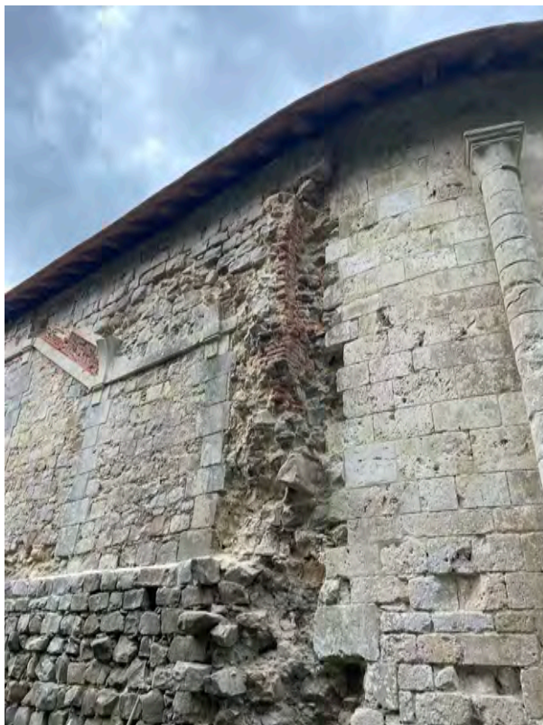
FIG. 47 : Vue depuis le sud sur la façade sud du chevet. On distingue l'UC3 à l'est avec le départ d'une colonnette (UC79), au centre le départ de mur UC14 et son arasement US9 et en-dessous le parement moderne de l'UC4. à l'ouest ont distingué le parement de l'UC16 avec au dessus le décors de l'escalier l'UC18 (Kévin Warau).
