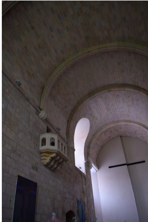
FIG. 63 : Vue de la voûte en berceau de la nef de Notre de l'Ouïye à Dourdan. Celle-ci a été détruite au XIX e siècle puis reconstruite selon l'originale (Anaëlle Genneret).
