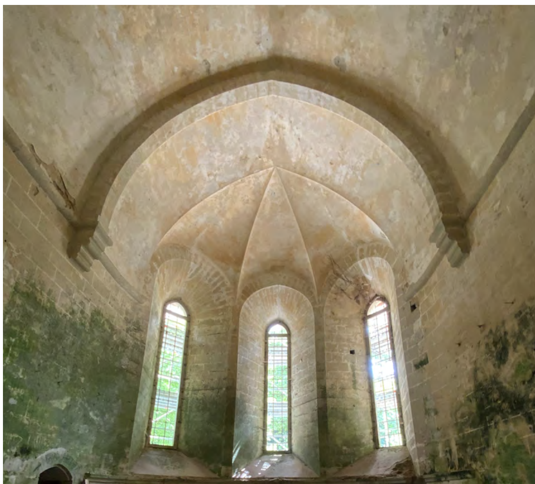
FIG. 57 : Vue générale depuis l'ouest sur les ouvertures de la façade est du chevet. De gauche à droite UC91, UC89 et UC90. On peut observer la l'enduit autour des ouvertures l'UC87 qui surplombe la corniche à cavet l'UC34. Au-dessus des ouverture on distingue l'UC36 l'enduit couvrant les voûtaïns du chœur (Aaron Gatt
